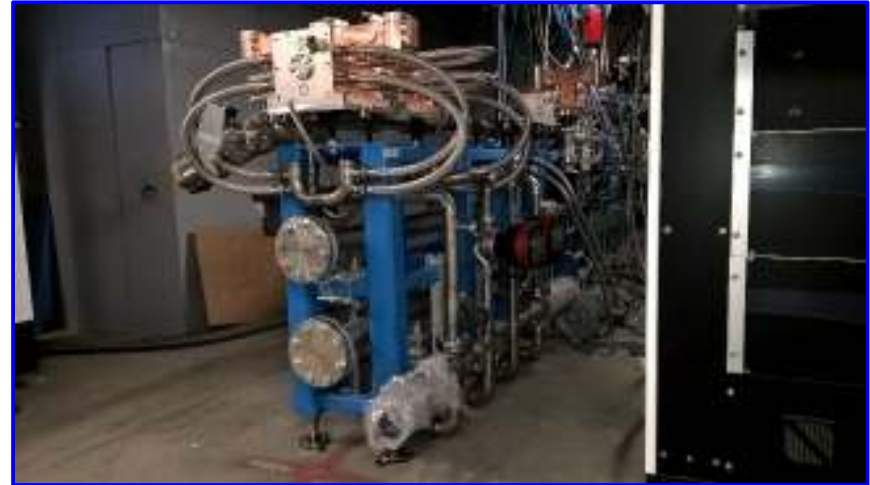
Circuito raffreddamento nuovo acceleratore Oncotherapy
