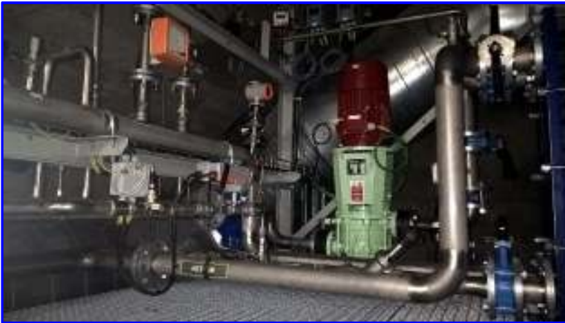
Montaggio pompa e nuovo circuito acqua
