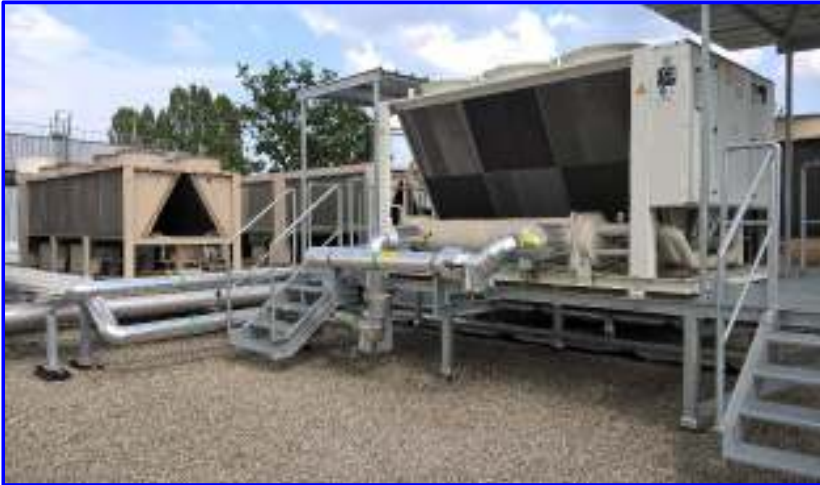
Circuito EG tetto BA03 ed isolamento
